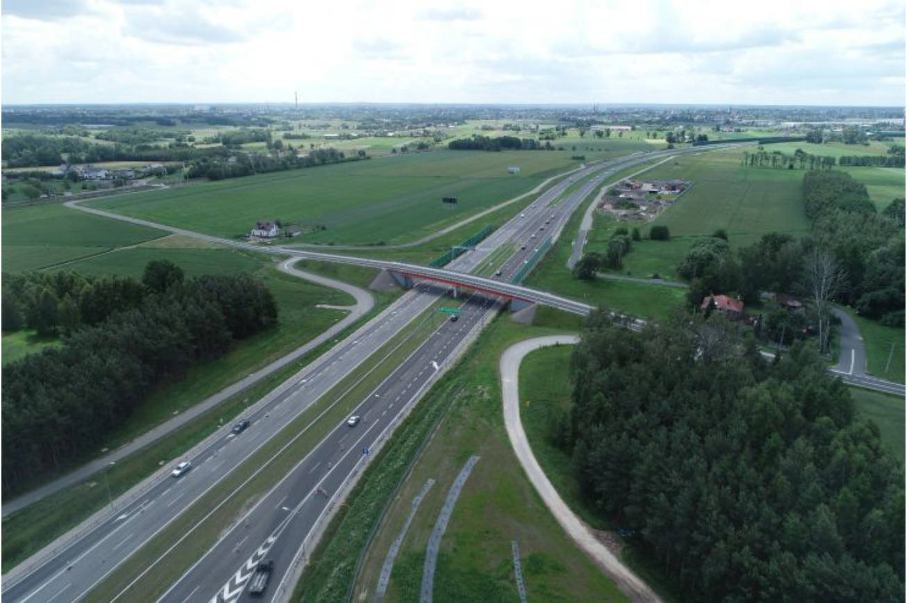
STRABAG Droga ekspresowa S14 – Zachodnia Obwodnica Łodzi fot. materiały prasowe STRABAG
