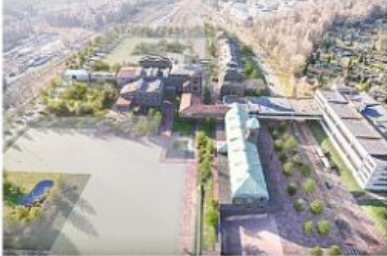
WIDOK Z LOTU PŁAKA W KIERUNKU POŁUDNIOWO-ZACHODNIEM
