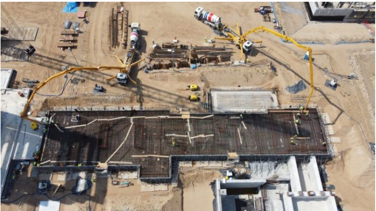
Wykonanie fundamentu pod turbozespół elektrowni
