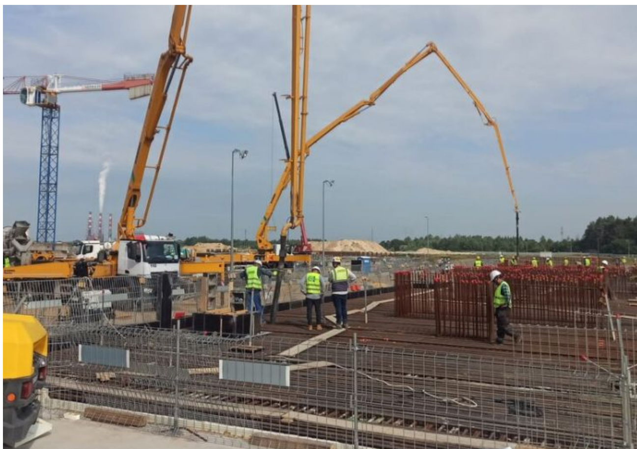
Wykonanie fundamentu pod turbozespół elektrowni1 fot. Grupa Energa
