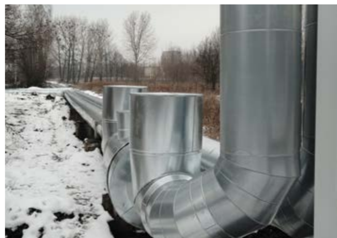
Sieć ciepłownicza po wymianie izolacji w Bytomiu
