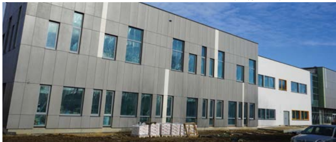
Zespół Szkolno-Przedszkolny w Wysokiej w budowie
