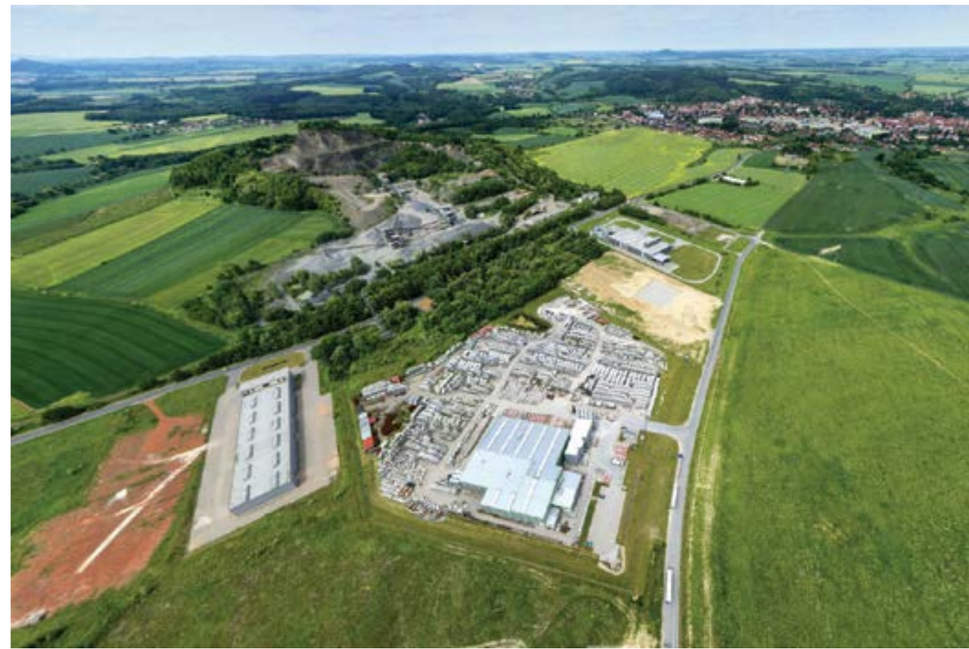
Podstrefa Złotyryja to najchętniej w ubiegłym roku wybierana przez inwestorów lokalizacja w LSSE. Wkrótce budowę fabryki rozpocznie tam firma Borgers Polska.
